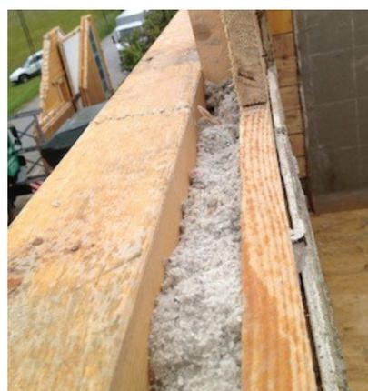
Que la cellulose dans les murs extérieurs et intérieurs est Intacte
