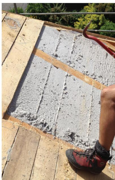
Ouverture d'un toit après 17 ans, on dirait que la ouate vient d'être insufflée
